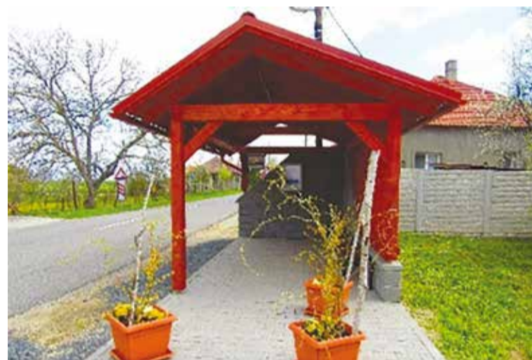
Rekonštrukcia prístrešku pri autobusovej zastávke - Kalonda
